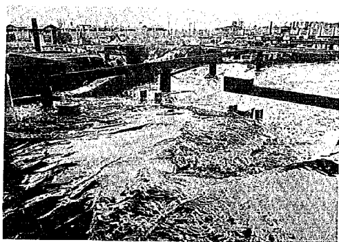
写真-20 ダム上流部流況を右岸上流部より ( Q=4,300 \text{ m}^3/\text{s} )
