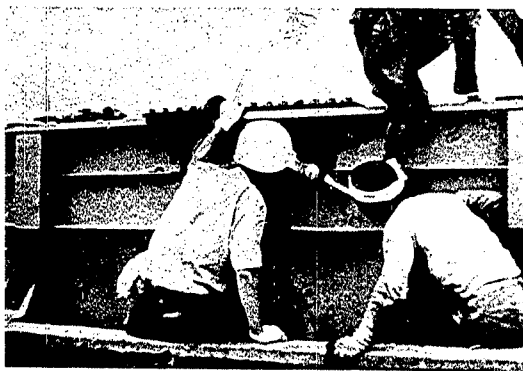
↑写真11 標準トルク導入と検査
