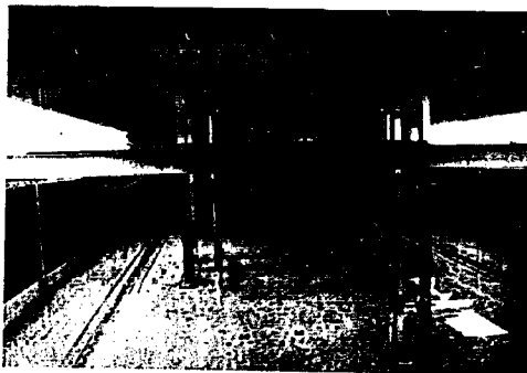
写真-8.3 水中橋脚模型実験
