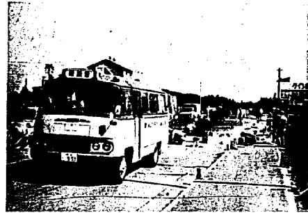
写真-9.5 薄層舗装現場試験
