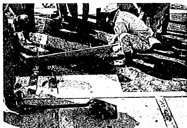
写真 2-3 木製定規でタンピング
