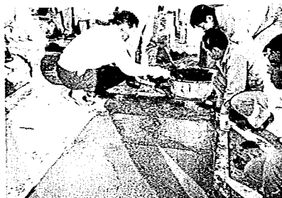
写真 6-4 こてで敷き均らし
