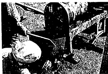
写真 2-1 クッカーより混合物排出
