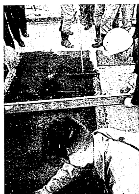
写真 3-3 木製定規でタンピング
