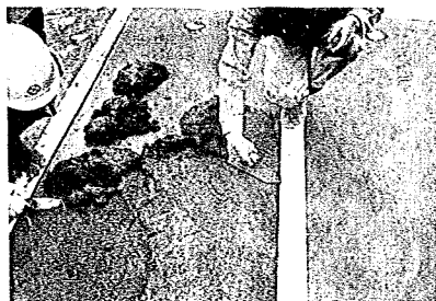
写真 3-2 こてで敷き均らし
