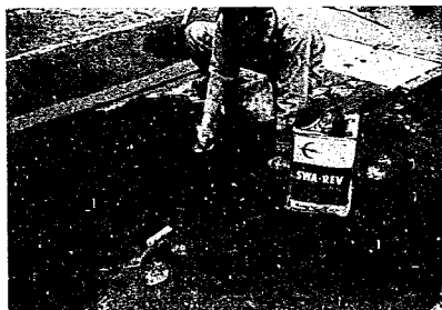
写真 8-3 こてで仕上げ
