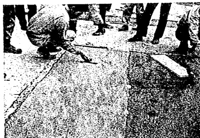
写真 4-3 こてで仕上げ
