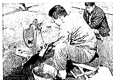
写真 10-4 すべり抵抗測定
