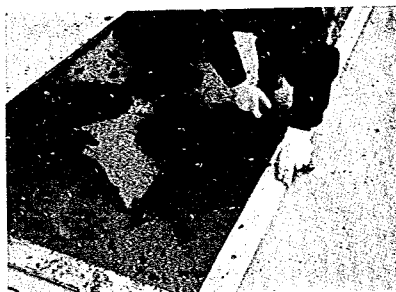
写真 7-3 こてで敷き均らし
