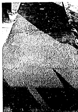
写真 6-5 上塗剤をぬらない前の舗装表面
