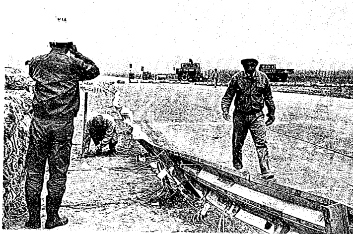
アルミニウムガードレール II型の変形状況
