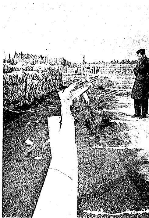
アルミニウムガードレール I 型 (高速道路用) の変形状況
