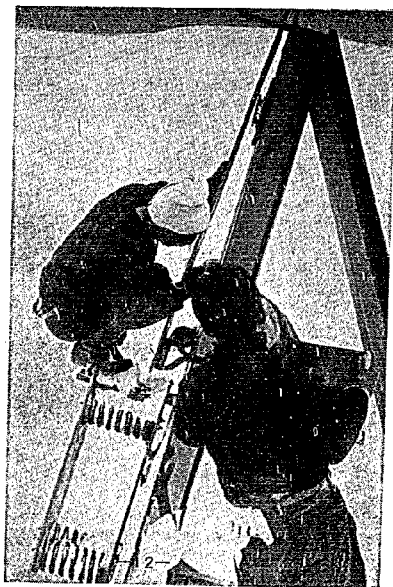
写真一8 圧痕計の取替え作業（妙高）
