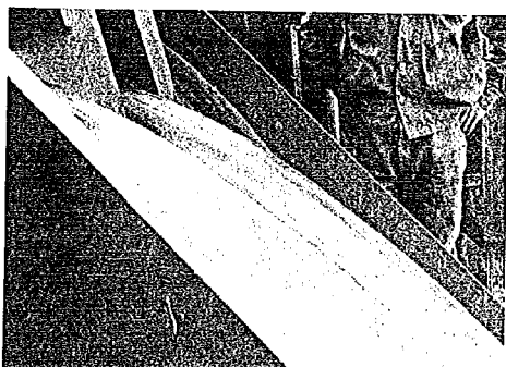
写真-6 孔口部ゲート全開時 流量 1560 m 3 /sec
