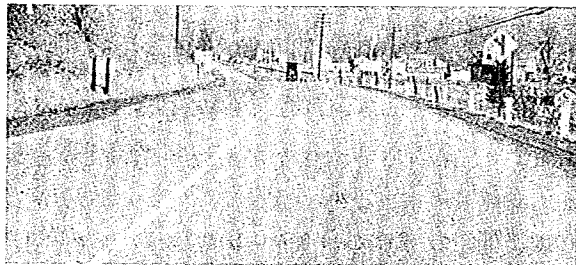
Figure 1: 導流化前，交差点から約300'離れた北行の流入部，交差点は道路の線形によって隠れていることに注意
