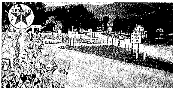
Figure 4: 導流化後、交差点の北行の流入部、ルート14は右、ルート15左、ルート14からの南行、交通はチャンネルを通っていることに注意
