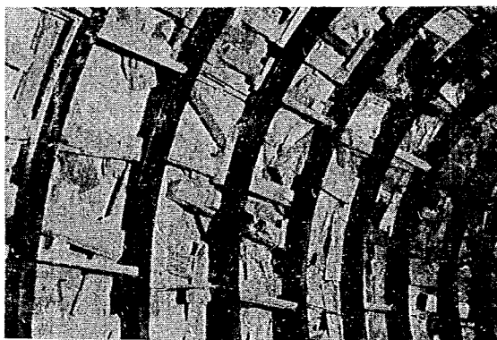
Fig 117—代表的なリブのブロック止めの例
