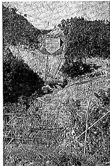
写真-11 現場一望
