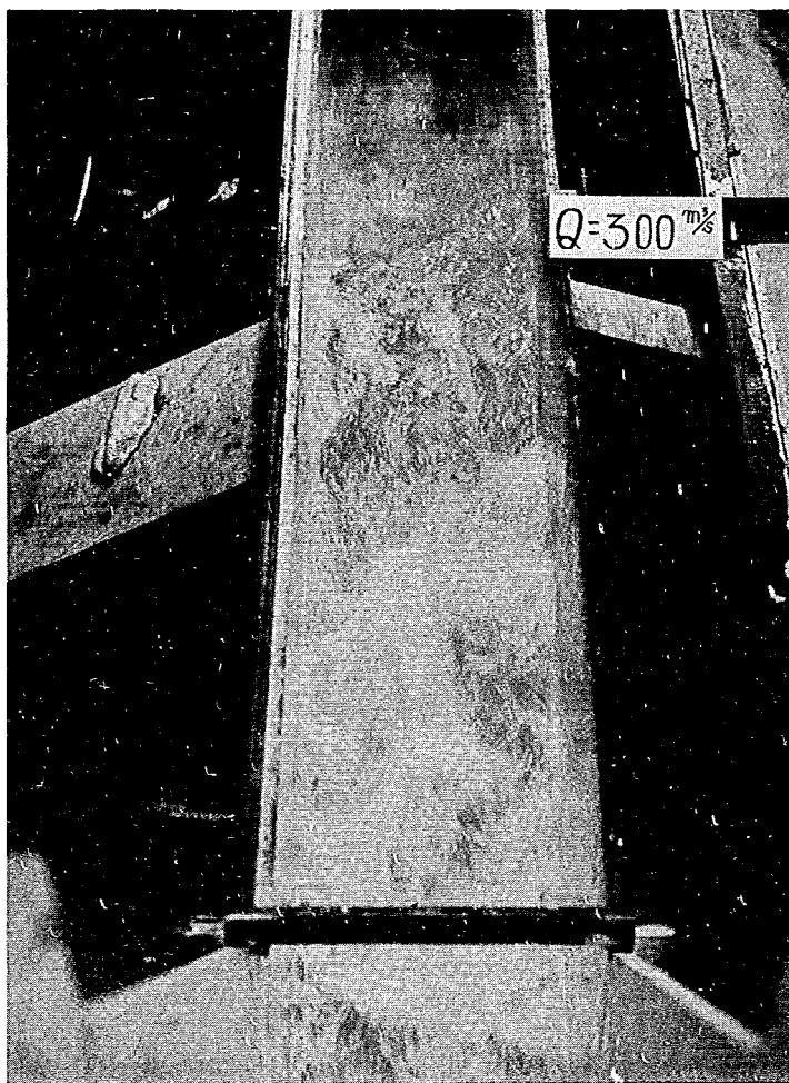
写真-5 300 \text{m}^3/\text{s} 放流時の流況（ダムより）
