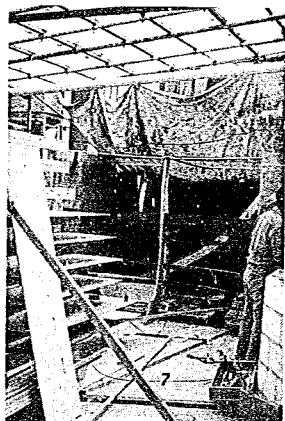
写 真 - 3 堤 体 型 枠 取 付 け
