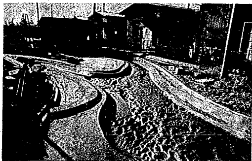
4. 実験後の河床の様子(改造前) (80.6kより下流を見る)
