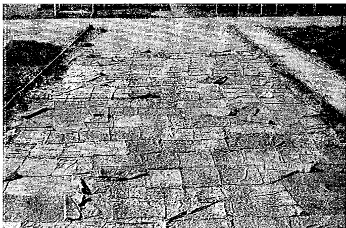
写真-6 ソイルセメント上層路盤のむしろ養生
