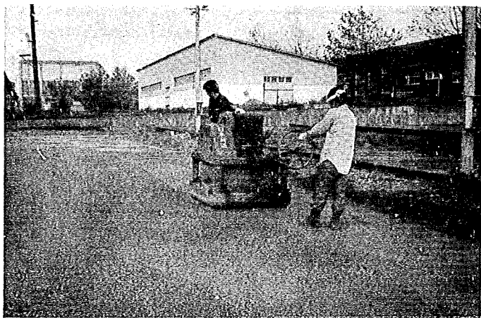
写真-2 ソイルセメントの転圧
