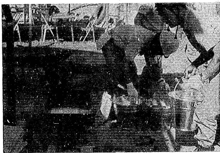
写真一 1 3 ホットビン骨材計量（ホット合成骨材）
