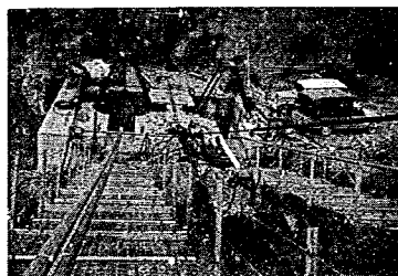
写真-2 4 右岸アンカー及びサイドスパン
