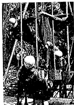
写真一48 ストランドサグ調整作業
