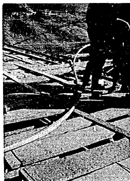
写真-40 引出しスタンド上のス トランドの型くずれ状況
