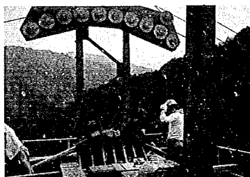
写真-2 2 塔頂曳索ガイドローラ及び塔頂サドル
