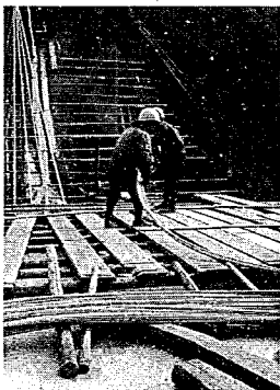
写真-39 ストランドの人力 による繰出し作業
