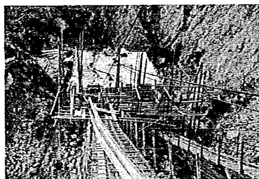
写真-12 左岸側アンカー部
