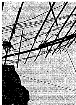
写真-38 サイドスパンのストラ ンド引出し状況(2)
