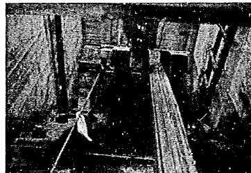
写真-56 スプレィサドルの素線の配列状況 (架線中)
