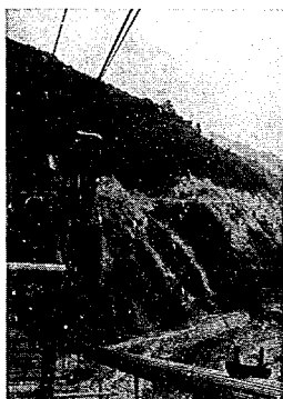
写真-2 3 スピーニングホール (2車式)
