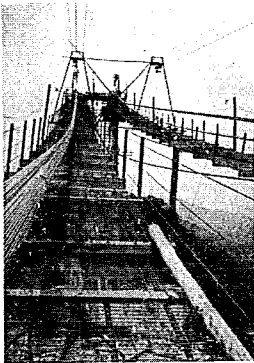
写真-15 左岸側サイドスパン
