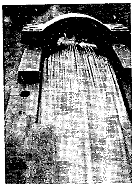
写真-59 サドル上の素線の 配列状況(2)
