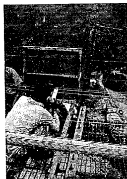
写真-28 センタースパン中央でのサグ測定状況
