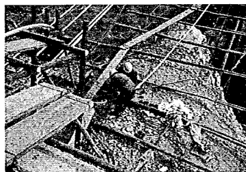
写真一46 ストランドのブレーキ用クリップの掛替え作業
