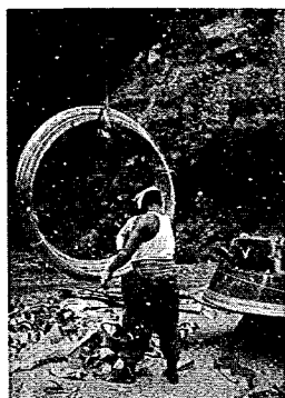
写真-81 現場リーリング(1) コイルの扱い状況
