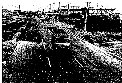
写真- 11 幕張試験舗装
