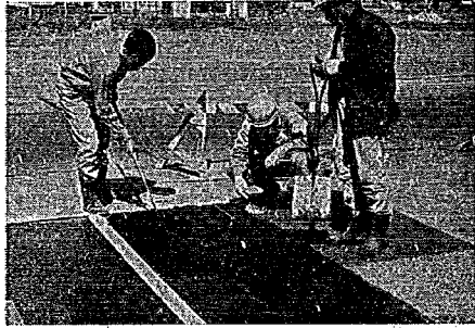
写真-7 ゴム入りアスファルトの敷きならし
