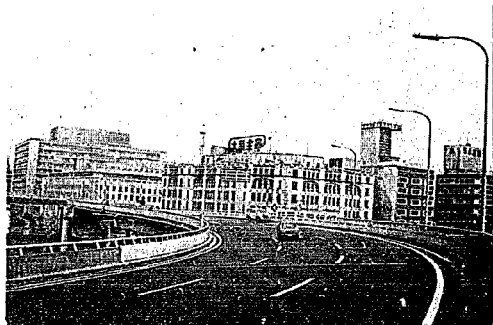
写真-21 阪神高速 S字橋
