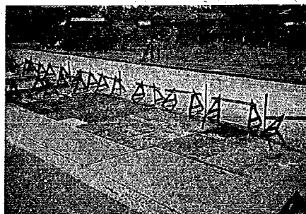
写真-2 薄層舗装状況
