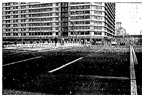
路面はわだち堀れ、亀裂はなく、極小のたてながけが認められる他は良好である。
