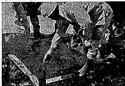
写真-9 グラスアスファルトのケップ散布
