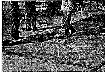
写真-10 舗装版の清掃 (エポキシ樹脂)
