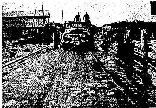
写真-12 実験終了時の路面状態(砂質土)
