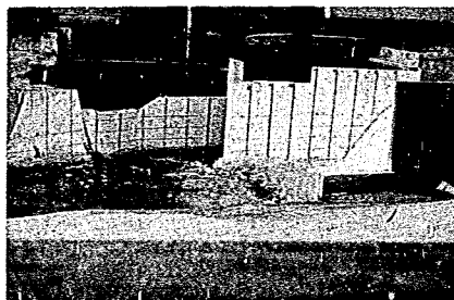
写真-6 ▮ 型段上げ水叩 水叩き長さ 1.5 m
