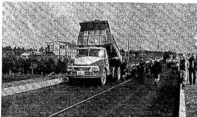
写真-31 表層敷き均し
