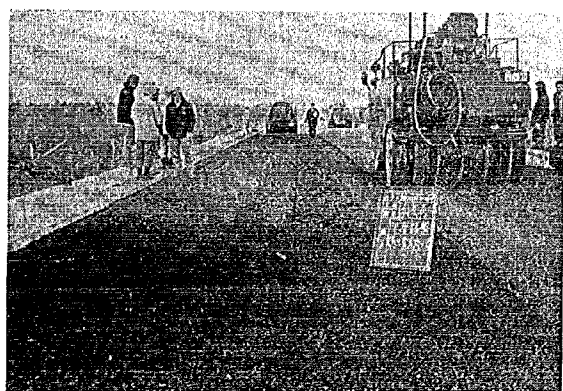
写真-9 タール安定処理敷圧
