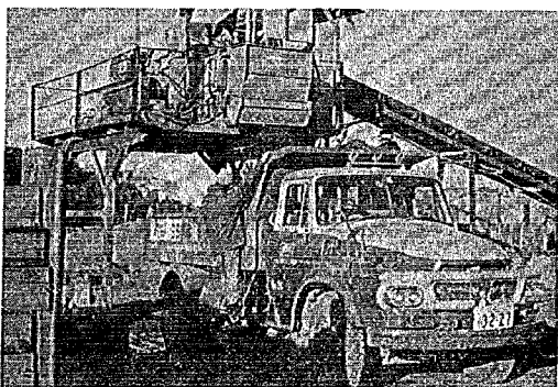
写真-12 セメント系および粒調 系の混合プラント
