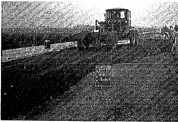
写真-17 粒度調整スラグ敷き均し
