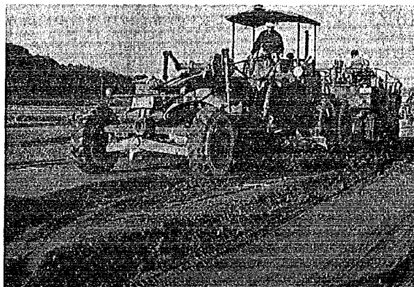
写真-3 ソイルセメントの敷均し
