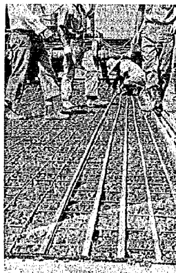
写真-14. 縁部補強鉄筋の取付け 作業(加古川バイパス)
