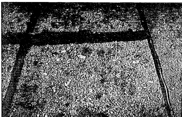
写真－２４ 天井部から剝離し火皿に落下した コンクリート
