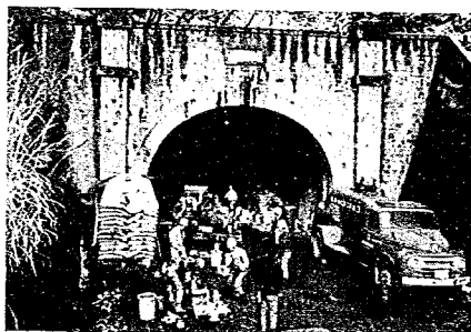
写真-26 注入機械、材料の配置状況
