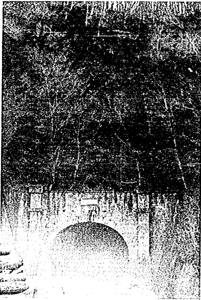
写真-1 ニツ小屋トンネル福島側坑口
