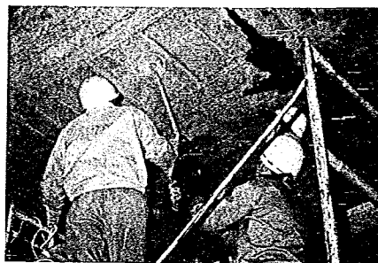
写真-24 注入孔、検査孔の削孔作業
