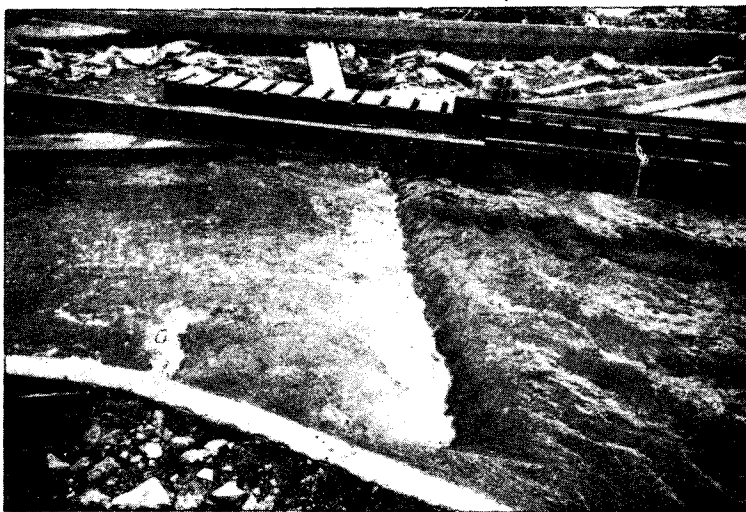
写真-8 庄手川 2.6 Km の左岸より分流堰附近の流況 (A案) [庄手川 350 m /sec流入]
