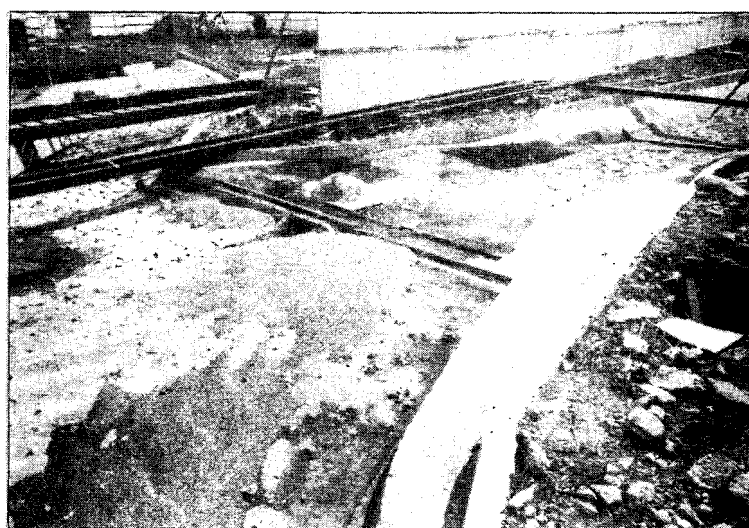
写真-22 7.5.15 km より下流分流堰附近の推砂状態(1時間通水路)
