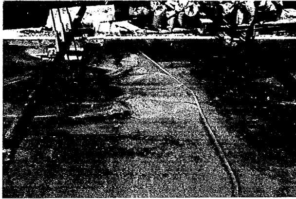
写真-31 床固工 9 付近の堆積状況を右岸より。(開始 120 分後)
