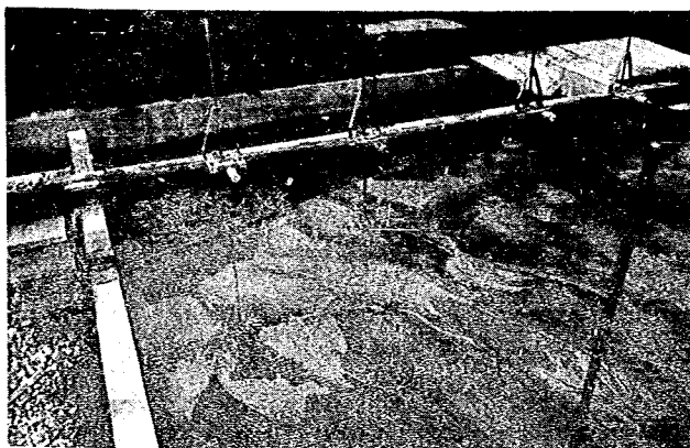
写真-28 床固工 8 付近の堆積状況を 1614 断面の左岸より。
