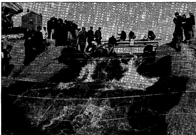
写真-18 NO.3 ( #300、土羽土30 m ) 区間における越流時間14分時ののり面状態
