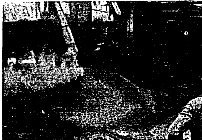
写真-6 骨材のオーバフロー
