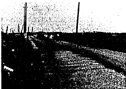
写真-11 基層上にタックコートの散布
