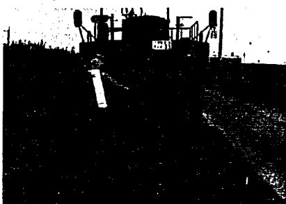
写真-13 タイヤローラに軽油の噴霧
