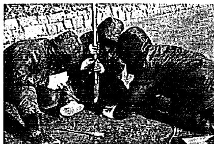
写真-2 SHブロック凍上量測定状況
