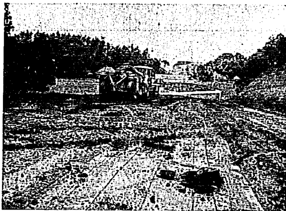
写真-1 白井現場
