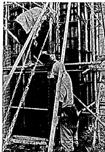
写真-10 打込み(円柱)
