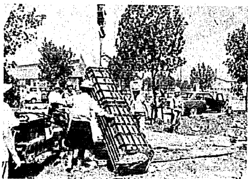
写真-15 角柱の横倒し(2)
