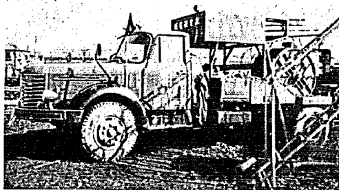
写真-8 コンクリートポンプ車
