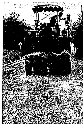
A-12のタイヤローラーによる転圧(同時散水)
