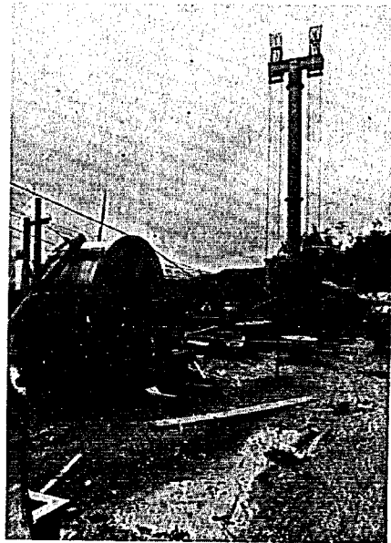
写真-13. エアスピニング用アンローラーと テンショングタワー (b)
