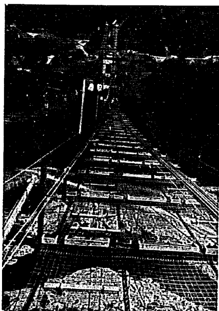
写真-6. 塔頂より中央径間を見る (AS工法ストランド用キャットウォーク)
