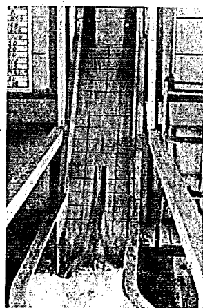
写真-9 越流面流下流況 (WL211.5m, ディフレクターなし)
