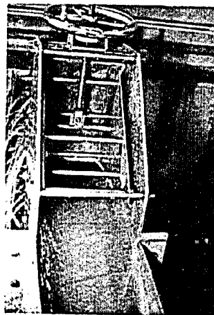
写真-7 放流管放流流況 (WL 211.5m, ゲート開度 3.6m)
