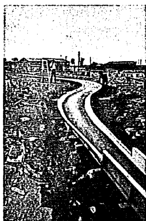
写真-19 S-II型 Q=270\text{m}^3/\text{S} 矩形部右岸より上流を見る。(最終案)
