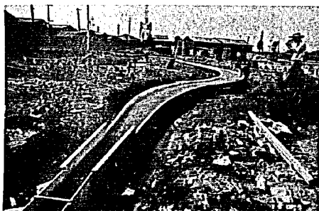
写真-20 S-II型 Q=470\text{m}^3/\text{S} 左岸側より漸縮部を見る。4.7mの堤防に 対し余裕高は小さくなっているが、S-I 型より大巾に水面は下っている。(最終案)
