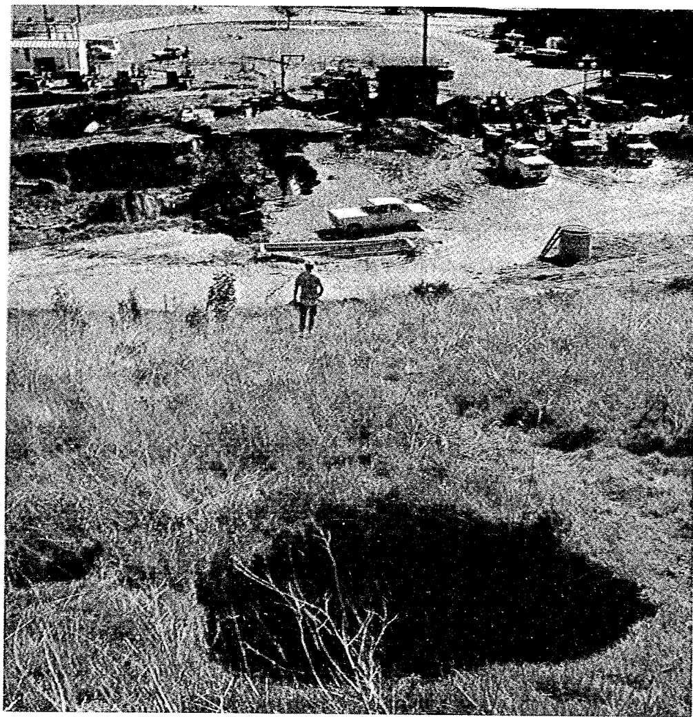
图-19 Upper San Fernando Dam 下流斜面
