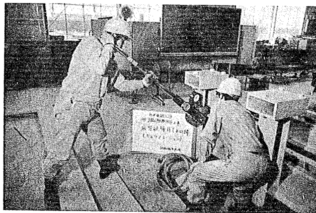
写真2 ボルト締め付け
