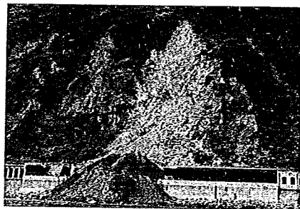
写真4.2.1 豪雨によるがけ崩れ (静岡県大崩海岸)
