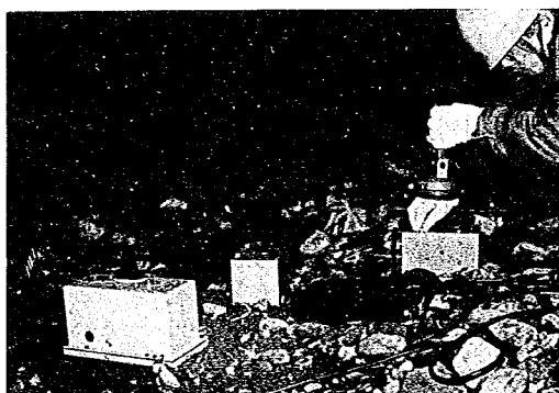
写真3. 橋脚地盤の計器配置
