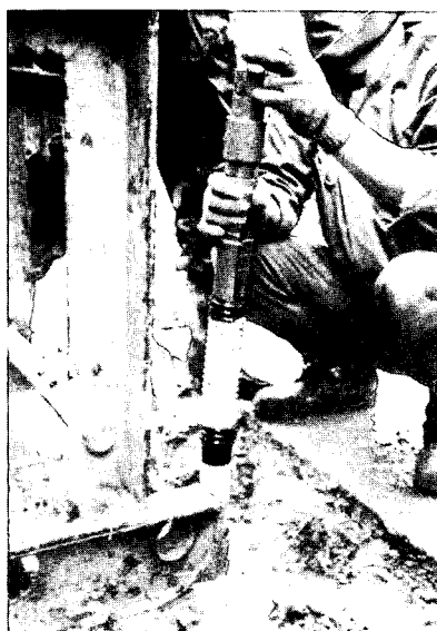
写真- 1.2 アンカー挿入
