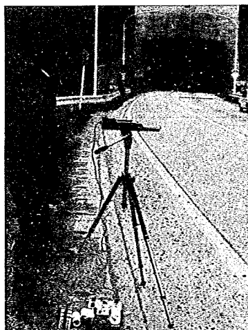
米沢側から坑口を望む
