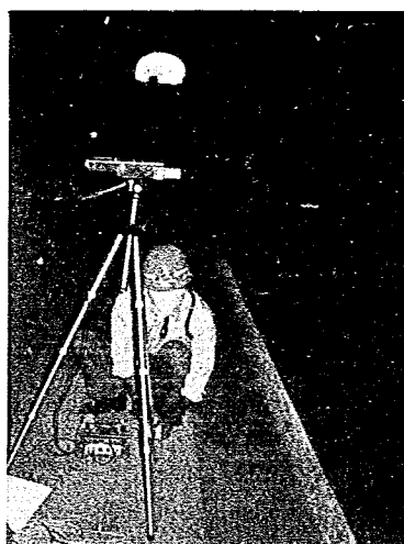
写真-1 トンネル内 (定点) 測定
