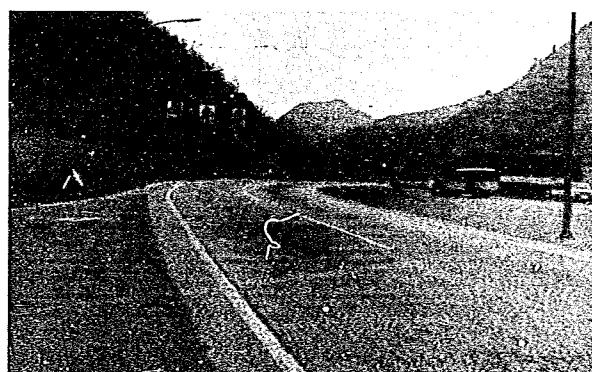
坑口から三米沢を望む
