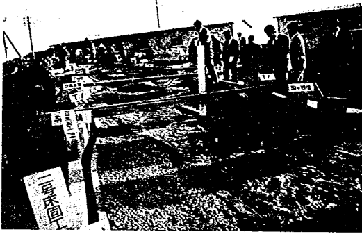
(1) 実験開始より15分後の上流部の流況
