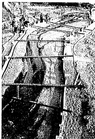
写真-1 太田切川流路工・模型床を 下流より上流を写す
