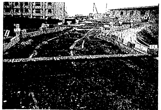
(4) 実験終了後、6号床固工付近より 上流部の河床状況
