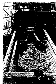
写真真-178 下流より
