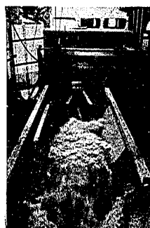
資写真-121 下流より
