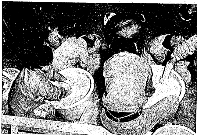
写真 - 5 岩盤打設状況
