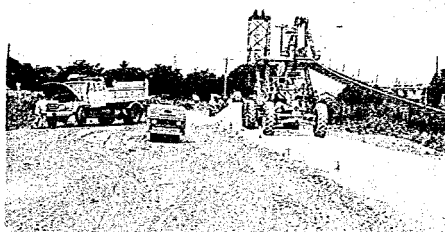
写真-4 路盤造成
