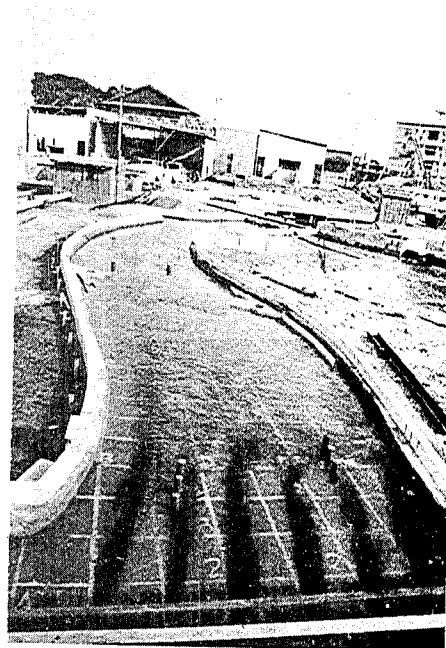
写真-7 1630断面より下流部の流況
