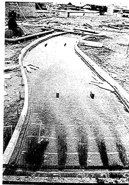
写真-10 No. 170断面より上流部の 流況。
