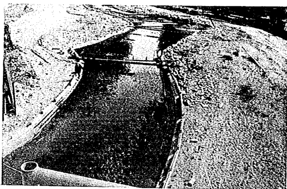
写真一6.1 3,500 \text{ m}^3/\text{sec} 36hr 8,000 " 4hr 通 水 後
