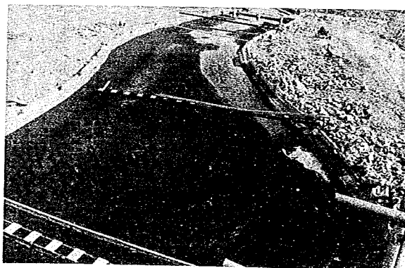
写真一6.3 3,500 \text{ m}^3/\text{sec} 36hr 8,000 " 4hr 通 水 後
