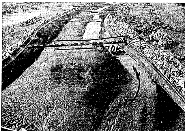
写真— 5.2 3,500 \text{ m}^3/\text{sec} 12hr 通水後
