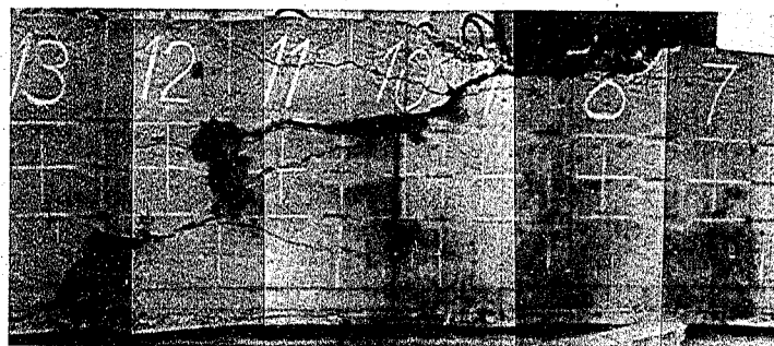
破 壊 状 況 写 真
