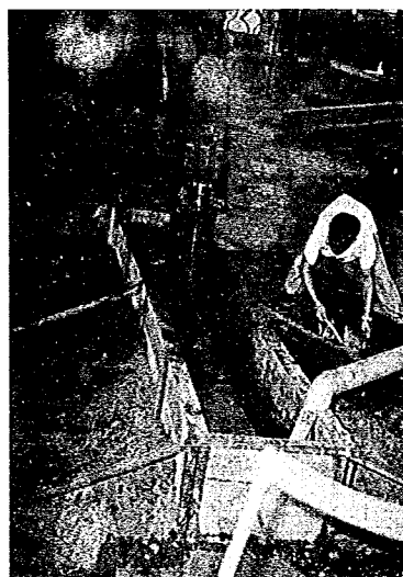
写真-3 トレンチの掘削(手前にみえる塩ビ管でベントナイトスラリーを投入している)
