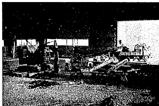
写真-2 スラリートレンチ工法実験全景
