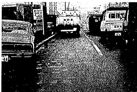
同左 また、下りは信号待ち、静止荷重及び制動荷重をうけるためいくぶん流動し平坦性は余りよくない
