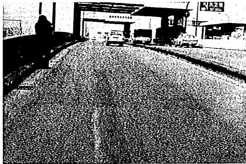
登坂部手前のスベリ止め表層（開粒）と後方の平坦部の修正トベカ表層
