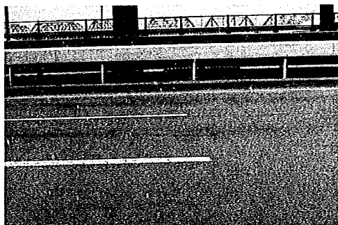
合材の不良によるとおもわれる極部的流動 （1m×2m）
