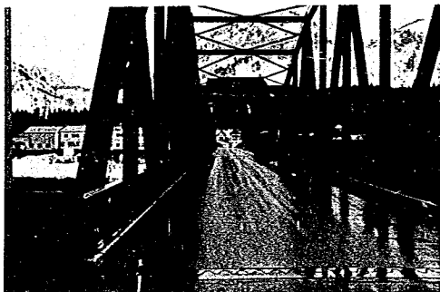
全景 48年10月、手前一径間を鋼床版（露工板）にて修善されたもの
