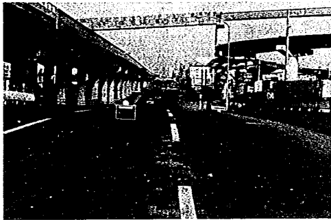
全景 全面オーバーレイしてある
