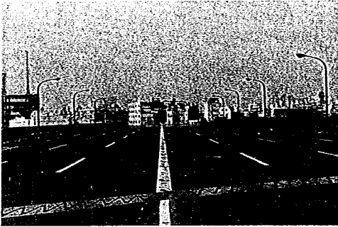
全景 クラックは非常に多いが、わだち掘れはなく、平坦性は良好
