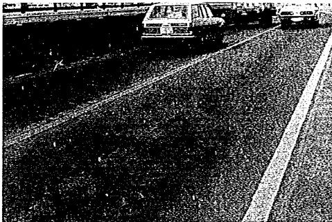
わだち部のスパイキローラ跡はうすれているがわだち掘れ、マモウはみとめられない
