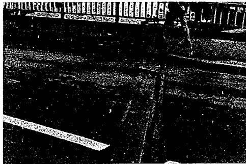
左が鋼床版 右は conc 床版 100余m先に信号があるためいくぶん制動荷重をうけるのか表層は車輛進行方向に流れている
