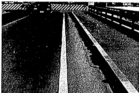
上り進入部は取付道と直角交叉しているため車の遠心力で側方流動が生じているのがレーンマークから判別出来る
