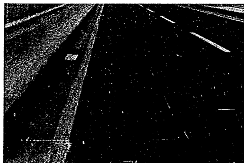
パッチング箇所は施工時手直し跡であろう いくぶんジョイントクラックが入っているが良好
