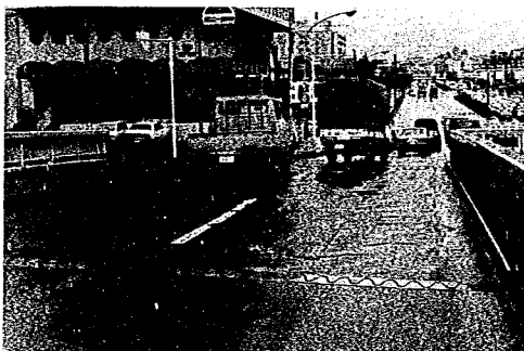
前方70.80m に信号あり 制動及び静止荷重をうける
