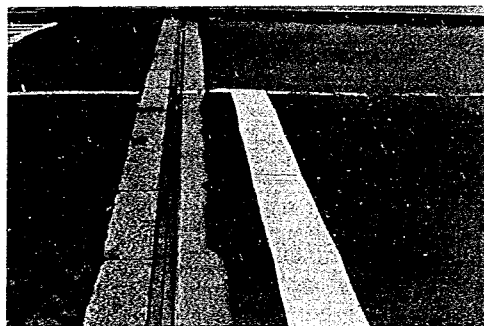
側径間の横断歩道手前のジョイント取付部は降坂部で制動荷重をうけ、わずかにたて流れを生じている
