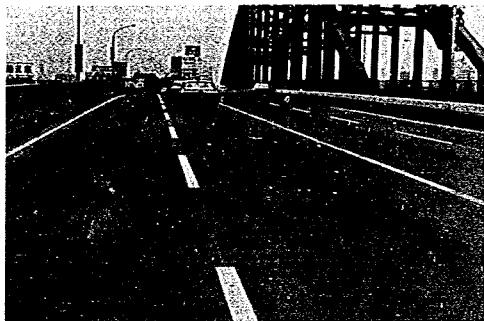
全景 レーンマークからも安定した路面状態が判る
