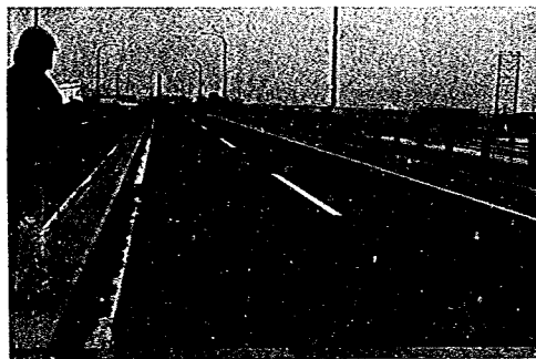
全景 わだち掘れは感じられる程度である
