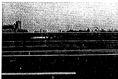
手前が上りオーバーレイ 後方は下りのグース 表層でウェービングしているのが判る
