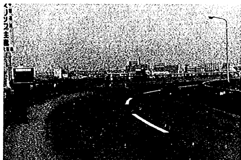
全景 曲線橋で終点部手前がもっともカントがついている
