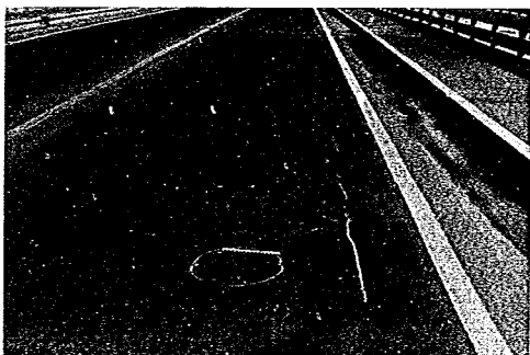
上り車線歩道マウンドアップから1.4 mの位置に長さ7~8 mにわたり縦クラックが発生していたのが唯一の線状クラック
