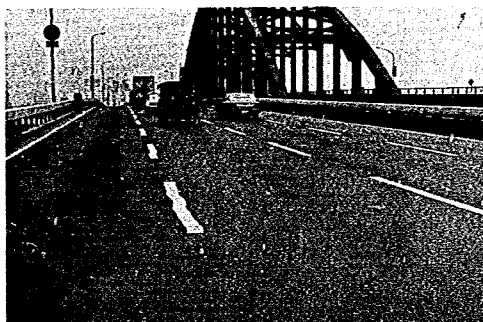
レーンマークの乱れから1部流動があるのに気づく（原因は合材のバラツキとおもわれる）
