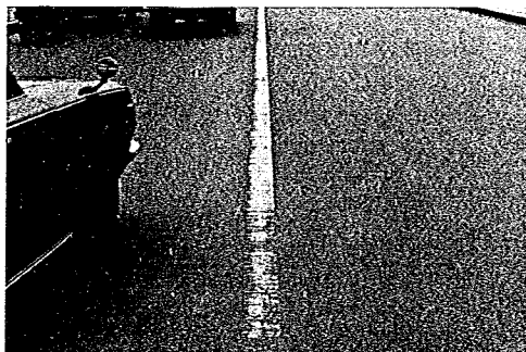
グース表層のスパイクローラ跡は路端を除き完全に消えている やゝマモウしているがワダチ掘れもなく平坦な安定した路面状態である
