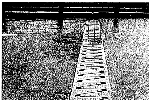
ジョイント左が鋼床版 右はconc床版 粗面はサルビアシム表層である
