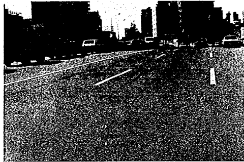
全景 交通量は多いが重量車の混入率は少い 上りはマモウがみとめられる以外、これとい った欠点はない
