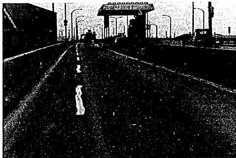
平坦部修正トベカ表層はレーンマークからい くぶん流動しているのが判る
