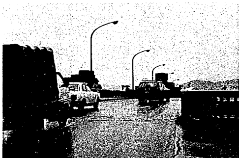
全景 太鼓橋の登坂部側径間 修正トベカでオーバーレイしてある
