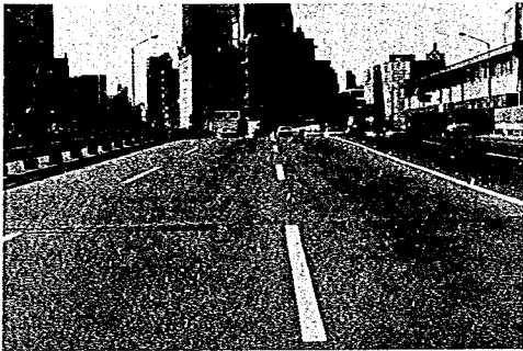
全景 平坦で安定した路面状態 わだち掘れは感じられない
